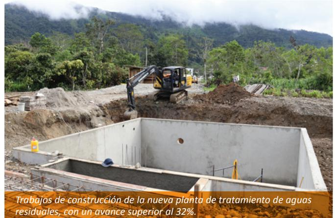
*Trabajos de construcción de la nueva planta de tratamiento de aguas residuales, con un avance superior al 32%.*
